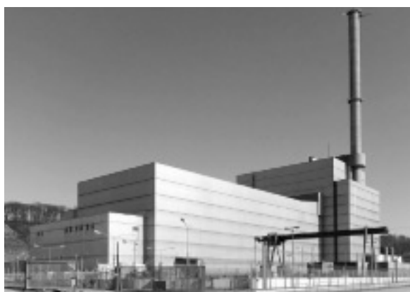
大統領令により2011年8月6日に恒久運転停止したドイツのKrümmel発電所 (Wikipediaより)
